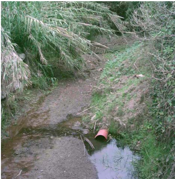
Vertido de aguas residuales sin control.
