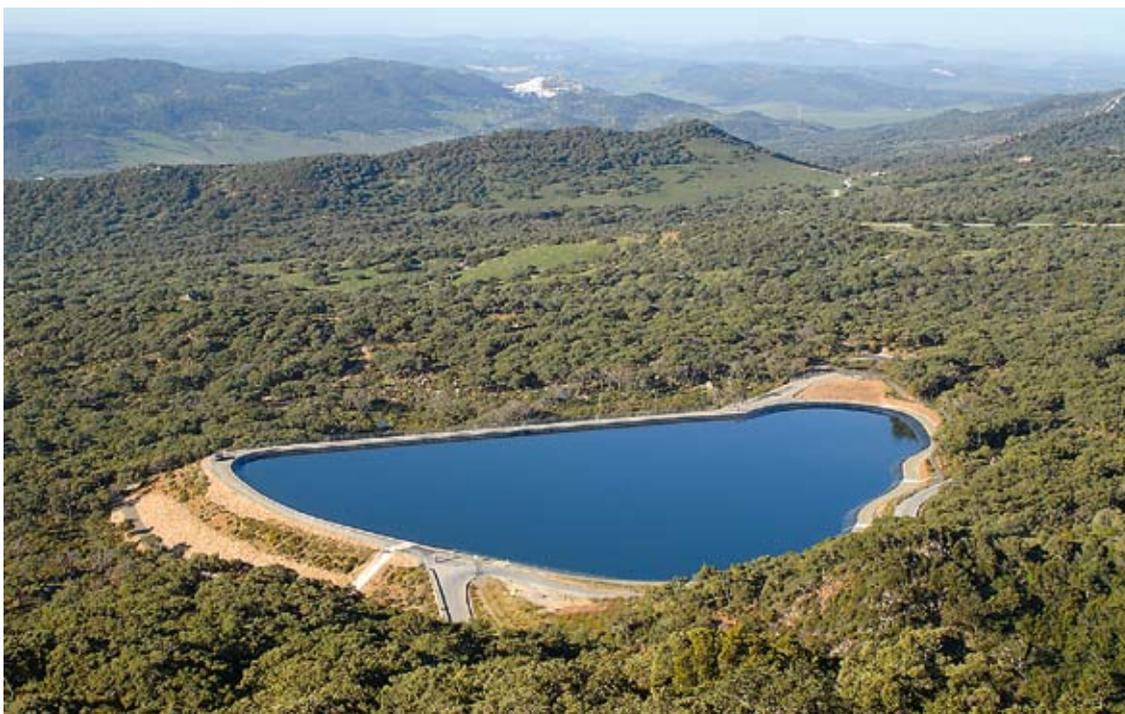
Balsa de la Garganta Montero. Con una capacidad de 220.000 m<sup>3</sup> está destinada al abastecimiento de agua potable a la población de Alcalá de los Gazules. Ubicada en pleno corazón del Parque Natural de los Alcornocales está construida de materiales sueltos. Durante el año 2006 se ejecutaron importantes obras de remodelación que incluyeron el revestimiento del vaso con lámina impermeable, la mejora del sistema de drenaje y el acondicionamiento de sus paramentos.
