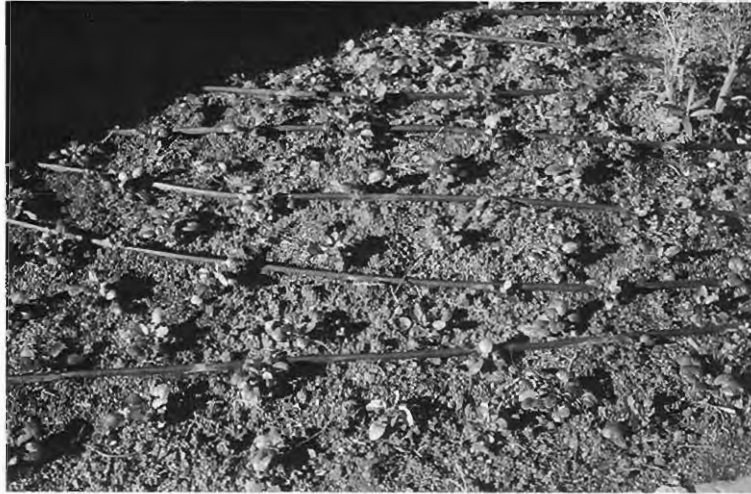
Figura 2. Sistema de riego localizado superficial.
