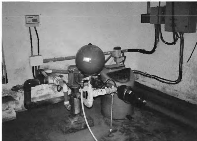
Figura 6. Cabezal de riego
