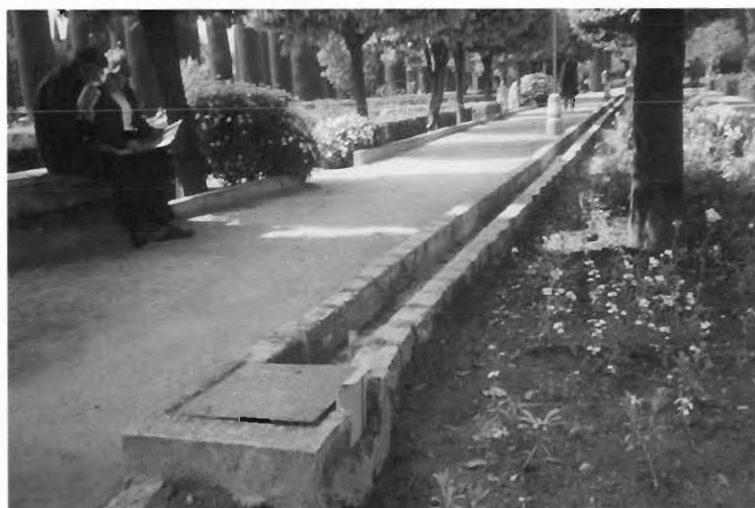
Figura 15. El uso de compuertillas regulables en los canales de riego, permite la práctica del recorte de caudal.
