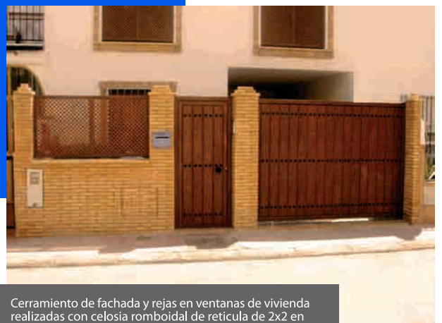
Cerramiento de patio realizado con celosía romboidal de retícula de 2x2 en aluminio imitación madera
