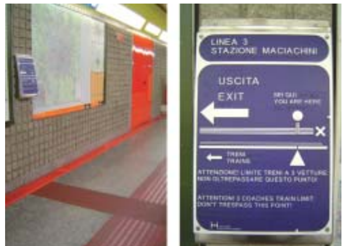
Señalización de plano en relieve mediante franjas guía de encaminamiento. Ejemplo de Plano en relieve con información direccional y textos en braille
