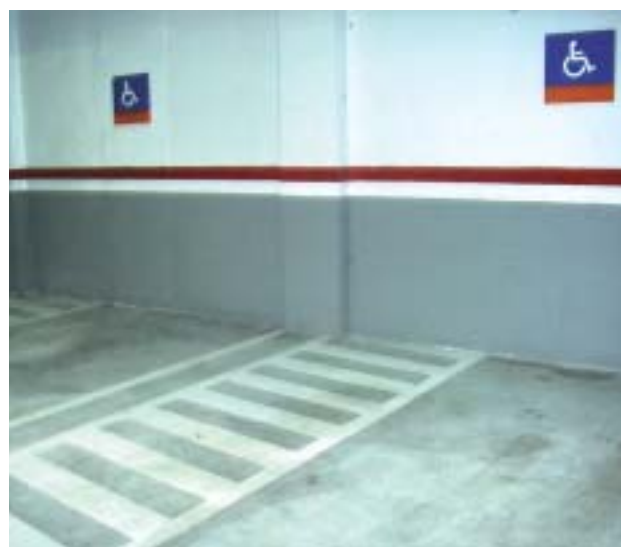
Buena práctica de plazas de aparcamiento reservado para personas de movilidad reducida
