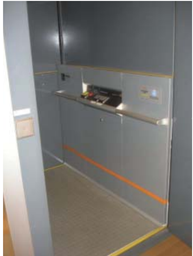
Cabina interior de ascensor con pasamanos y botonera accesible
