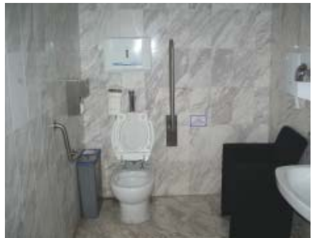
Barra fija en el lado de la pared y abatible en el lado de la transferencia. En la segunda fotografía se requiere quitar el asiento para no reducir el área de maniobra de la persona en silla de ruedas
