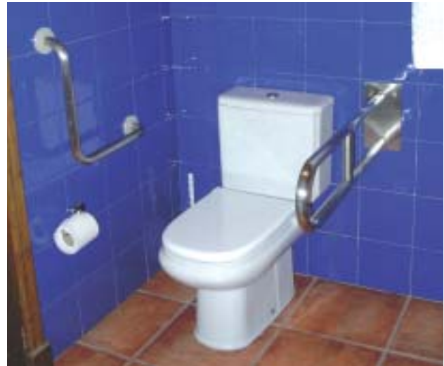
Barra fija en el lado de la pared y abatible en el lado de la transferencia. En la segunda fotografía se requiere quitar el asiento para no reducir el área de maniobra de la persona en silla de ruedas
