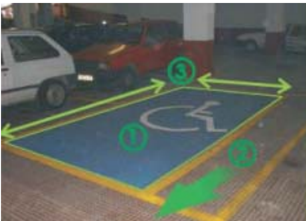
Señalización horizontal de plaza de aparcamiento reservada
