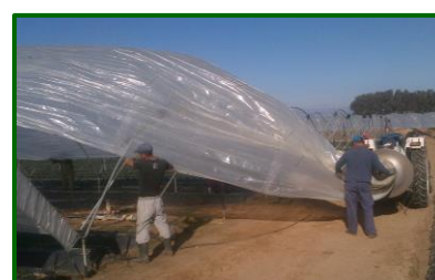
Colocación de plásticos
