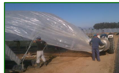
Colocación de plásticos
