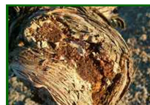
Daños por termitas
