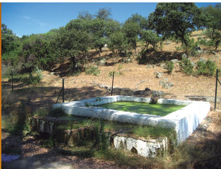
A menudo, estas infraestructuras tradicionales han caído en desuso encontrándose muchas de ellas en mal estado de conservación e incluso secas debido a la obstrucción de la canalización de agua de la que se abastecían o por derivación de la misma hacia otro punto.
