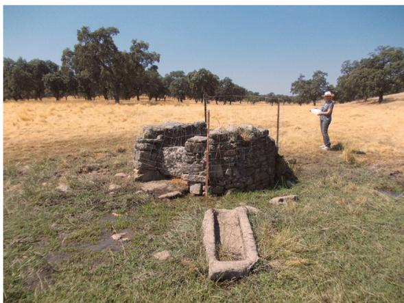
Foto 52. Brocal de un pozo construido con piedras en deficiente estado de conservación y abrevadero adjunto de una sola pieza.
