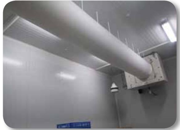
Figura 76. Evaporador cúbico con mangas
