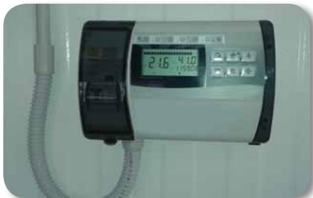
Figura 78. Sistema de control de cámaras
