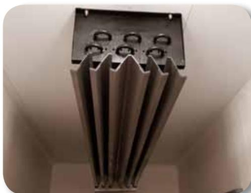
Figura 73. Evaporador estático
