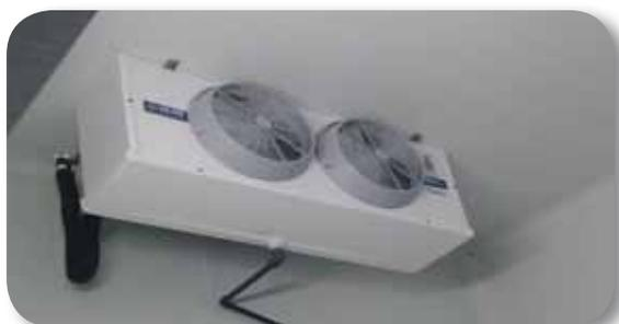
Figura 75. Evaporador cúbico
