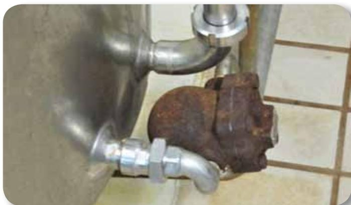
Figura 9. Corrosión en valvulería por uso de material inadecuado
