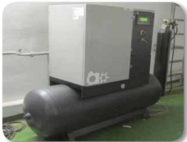
Figura 96. Compresor para instalaciones neumáticas
