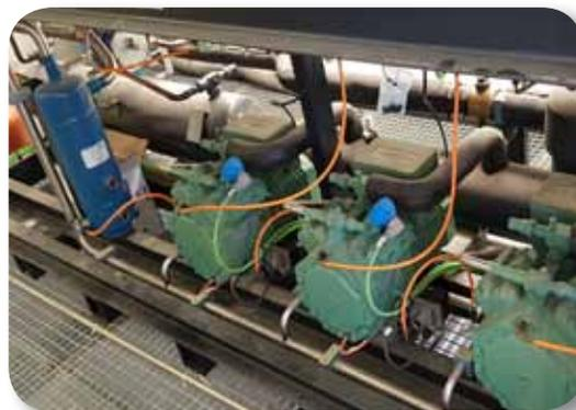
Figura 77. Compresores en paralelo de central frigorífica
