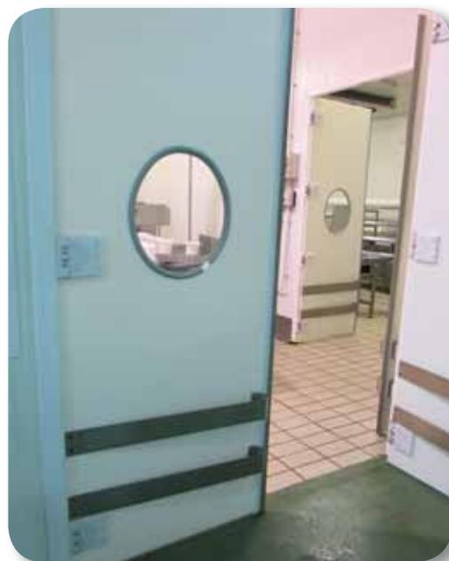
Figura 6. Puerta batiente: polietileno con protecciones de acero inoxidable
