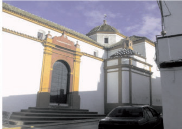
Fachada a calle Andrés Bernaldez
