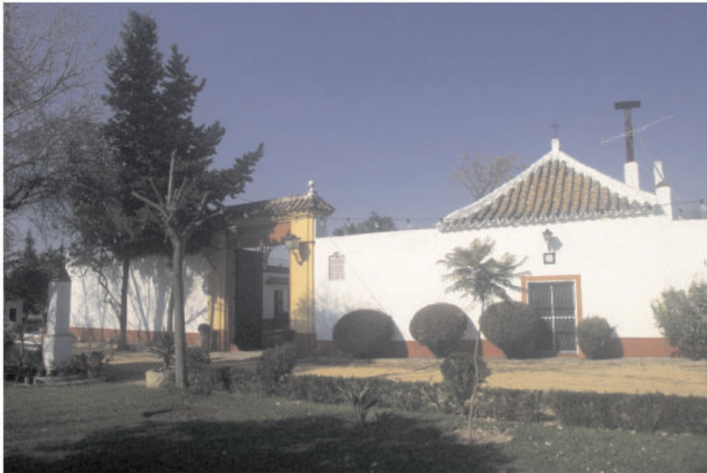
Acceso en fachada principal.
