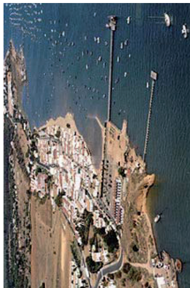
Instalación portuaria El Rompido
