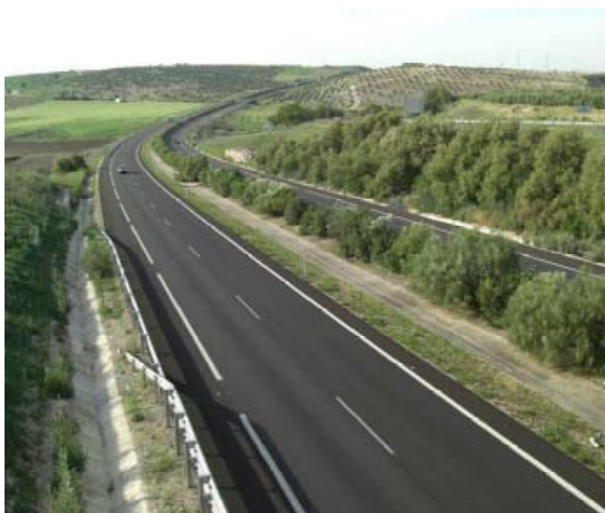
Autovía A-44 Bailén-Motril
