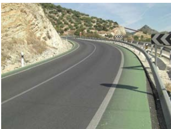
Carretera A-6050 (vía multimodal Jaén-Los Villares)
