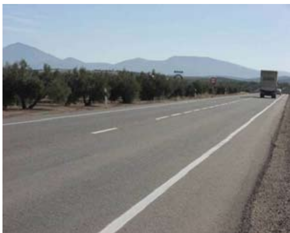
Carretera A-306 (El Carpio-intersección con la A-316 en Torredonjimeno), con previsión de desdoblamiento
