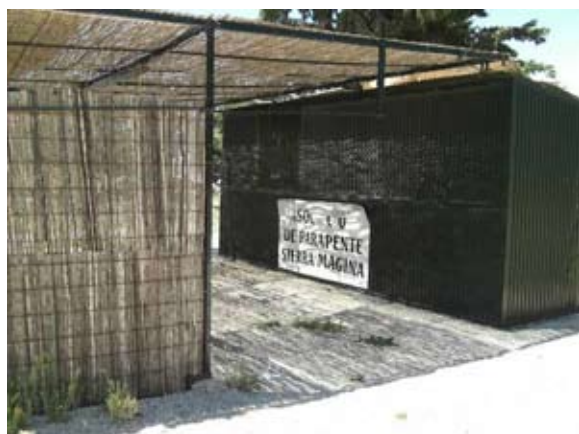
Instalaciones actuales de la zona de despegue de Siete Pilillas (Pegalajar)
