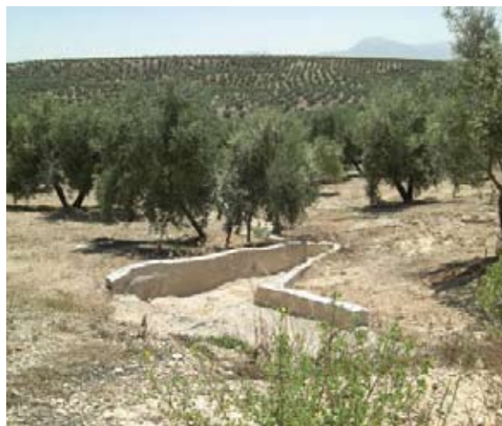
Canalización para aguas pluviales en zona de campiña olivarera (Villatorres)
