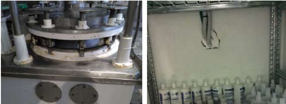
Foto 1. Ejemplos de falta de mantenimiento en equipos
