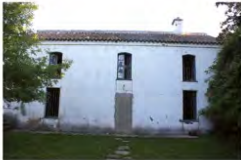
Fábrica de San Nicolás del Puerto (Sevilla) 04/2011
