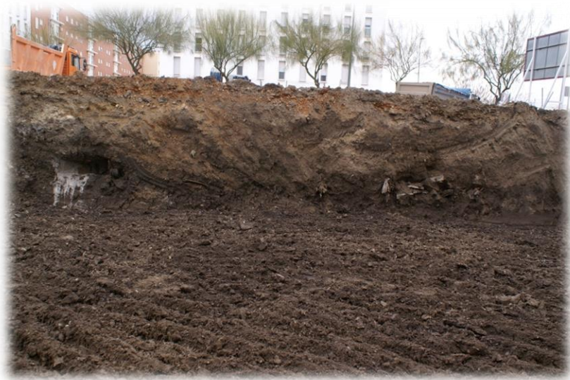
Fig. 3 Detalle de afección
