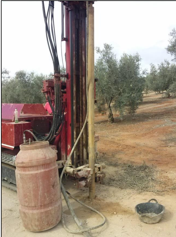
Foto 3. Máquina realizando el sondeo.
