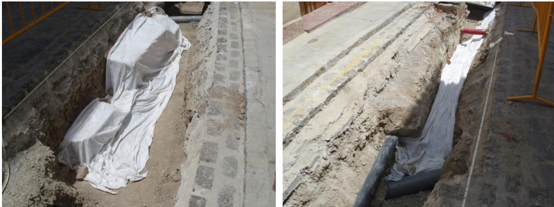
Lámina 10 y 11. Proceso de cubrición de los restos con tela geotextil.
