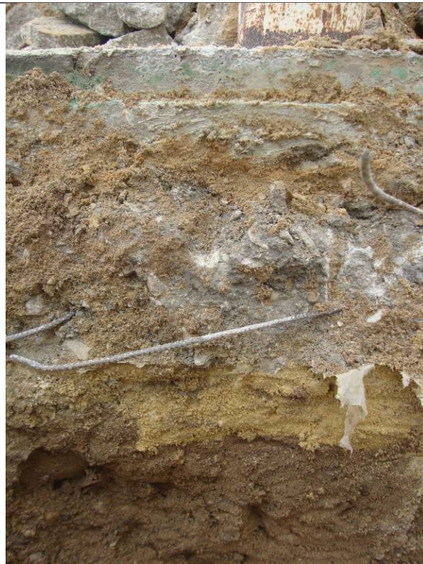
Estratigrafía: hormigón armado, subbase y relleno.
