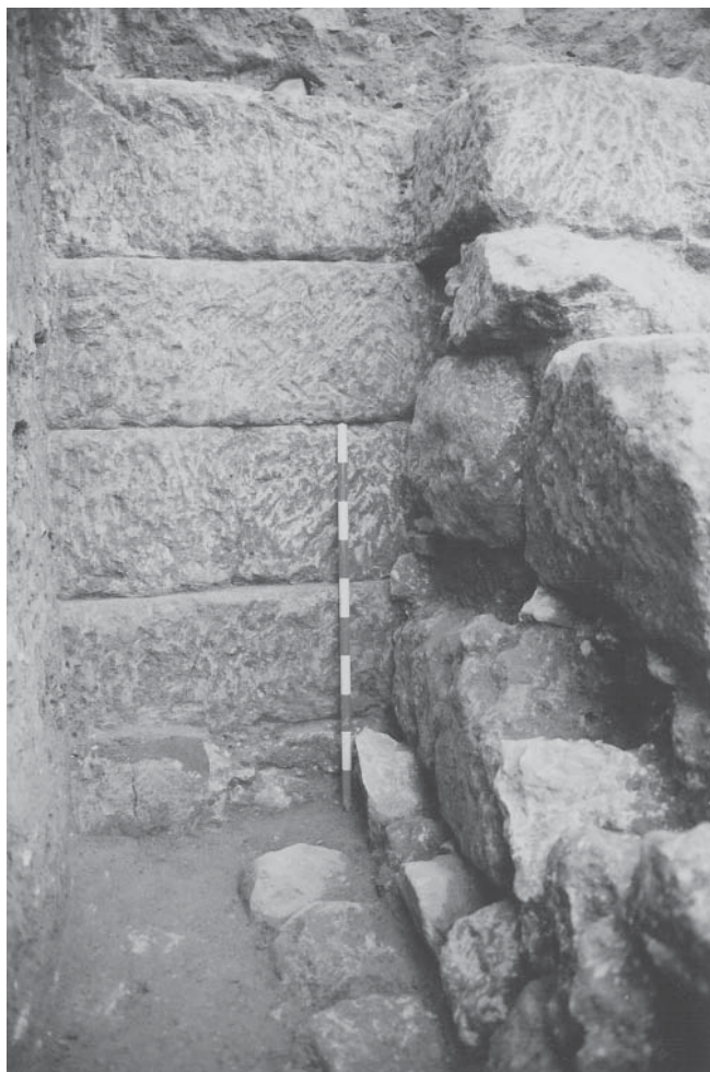
LÁM. III. Corte 2. Detalle del muro de opus quadratum (U.E. 33) con restos del enlucido pintado en la parte inferior. A la derecha, el muro U.E. 18 tardorromano que se le adosa.
