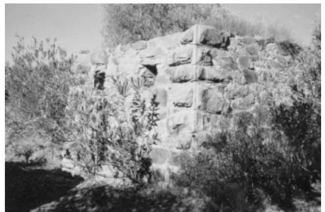
LÁM. III. Tramo E. Puente P-4.
