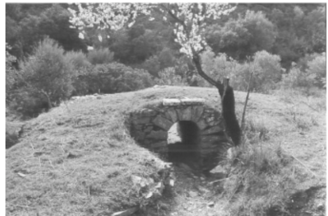
LÁM. II. Tramo E. Alcantarilla 1.
