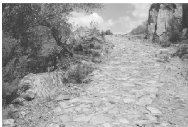
LÁM. I. Tramo Sur. Tramo empedrado.
