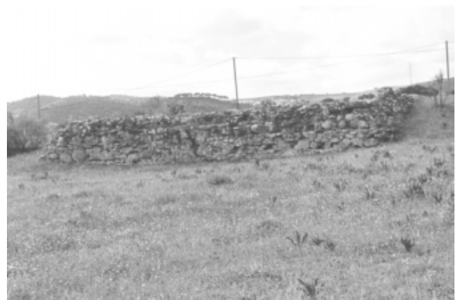
LÁM. I. Vista General Exterior de los Muros Norte y Oeste del Castellum Aquae .
