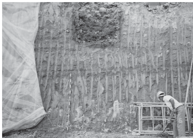
LÁM. 3. Sección del horno y perfil de arcillas en el que se inserta y sobre el que fue instalada la necrópolis medieval.
