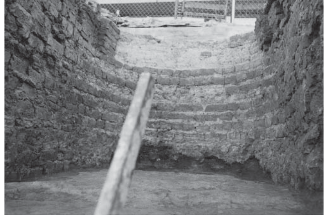
LÁM. 6. Detalle de los alzados parietales del interior de la cámara del horno.
