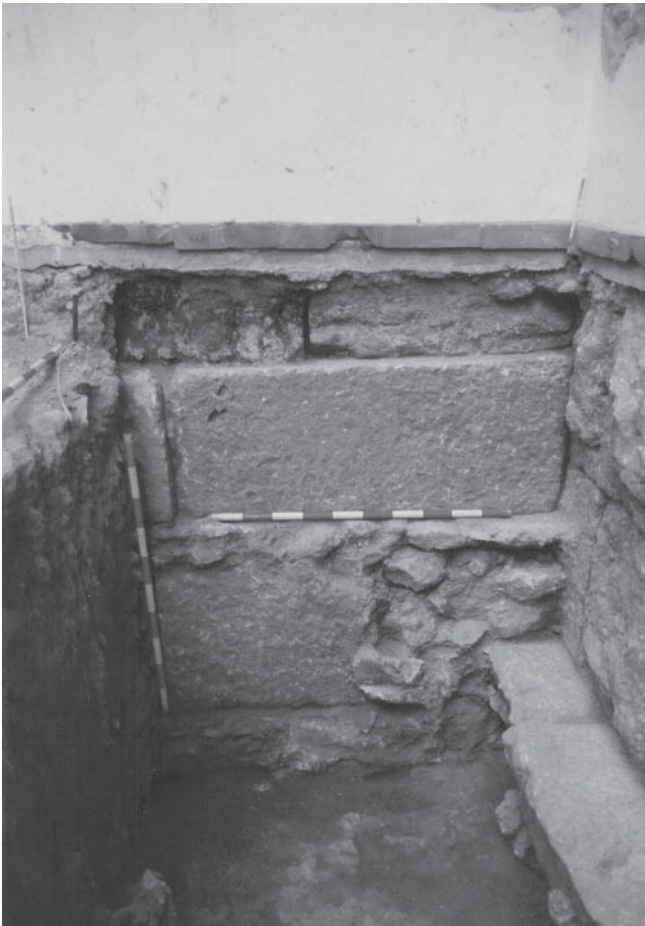
LAM. VI. Detalle cimentación lienzo sur fortaleza. Corte 2.
