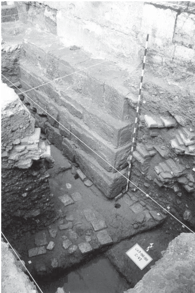
LAM. I. Zapata de argamasa en la base de la fundación del alminar. Esquina suroriental. Corte VI. Los ladrillos y restos pétreos visibles en ella pertenecen al vertido tras haber perdido una capa superior de cal.
