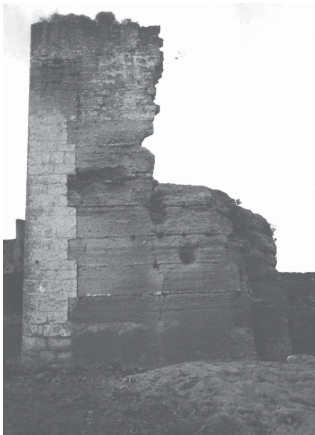
LÁM. II. Vista del alzado norte de la Torre 8.
