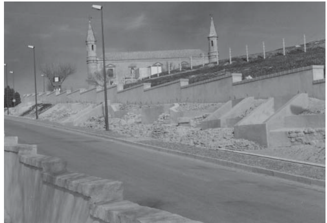
LAM. V. Estado final de la calle.
