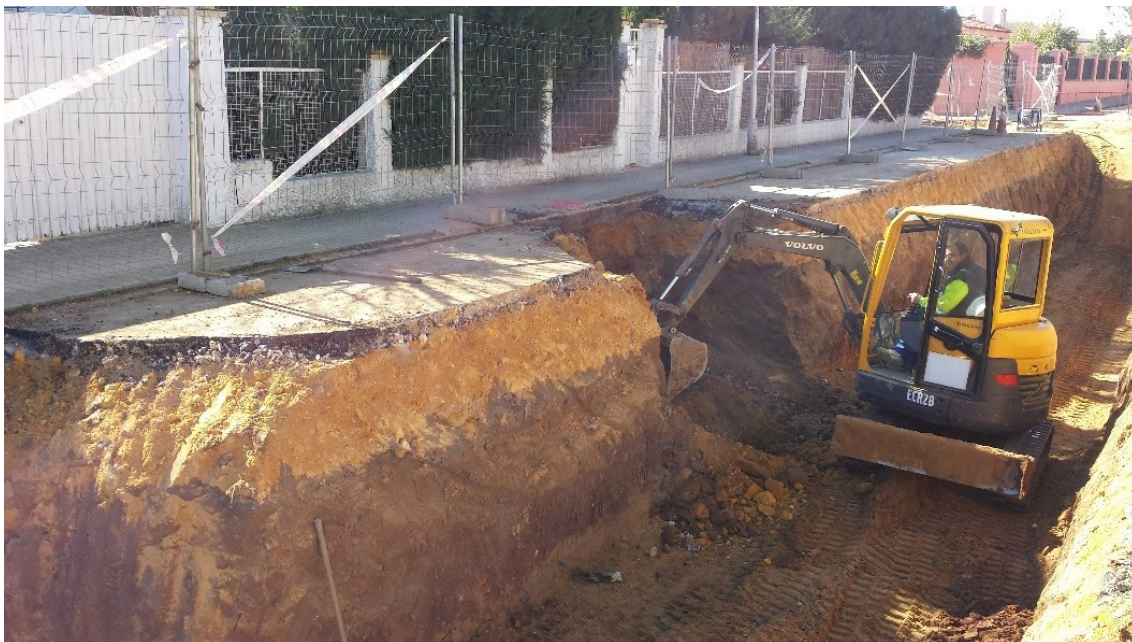
LÁMINA 5: Trabajos en sector C/ Huelva.
