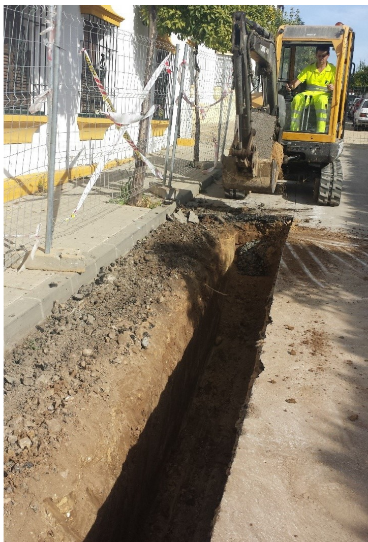
LÁMINA 6: Trabajos en sector C/ Alfonso Grosso.
