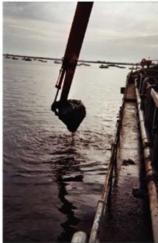
PROCESO DE DRAGADO CON EXCAVADORA
