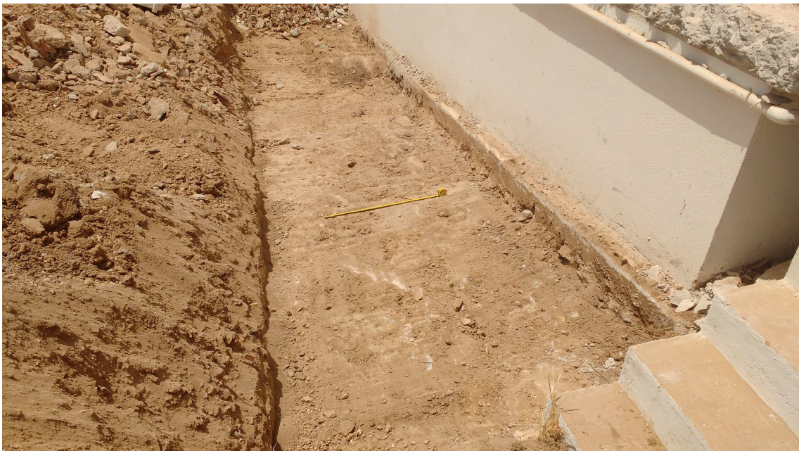
Lámina 2. Detalle de la zanja de la piscina
