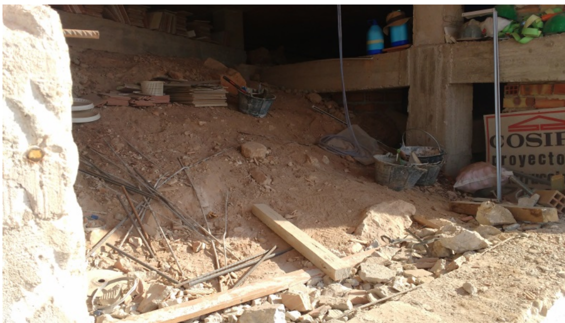
Lámina 8. Rebaje del sótano
