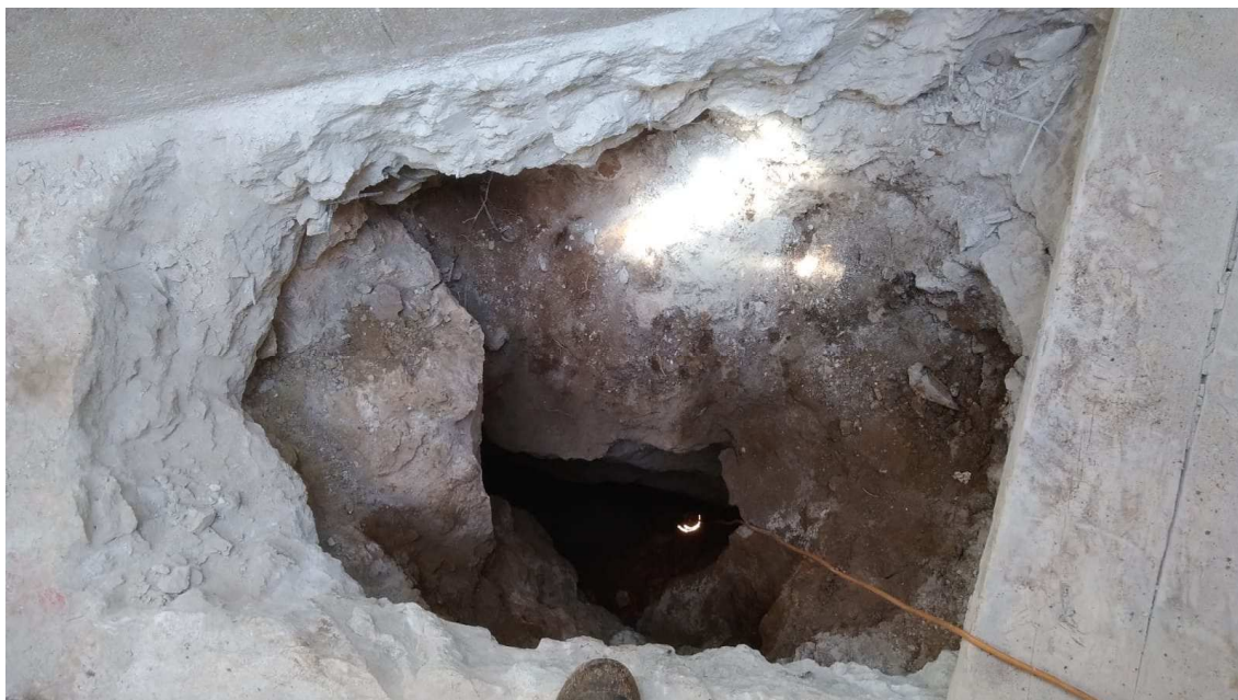
Lámina 4. Entrada a la diaclasa en el hueco del aljibe
