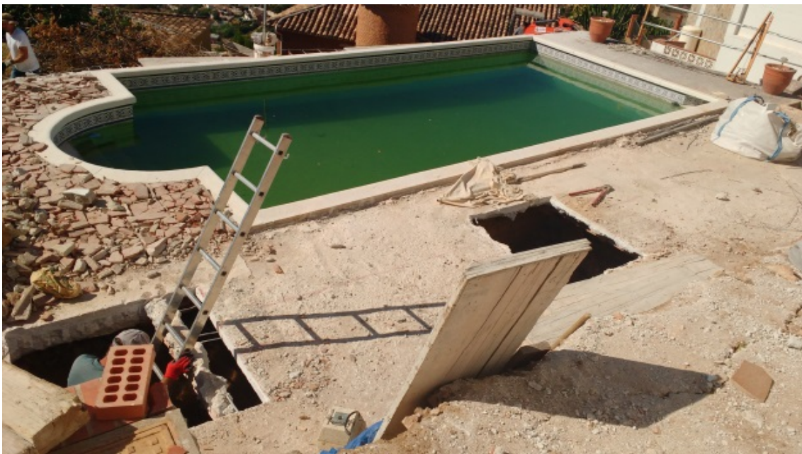
Lámina 3. Ubicación de los huecos para los pilares
