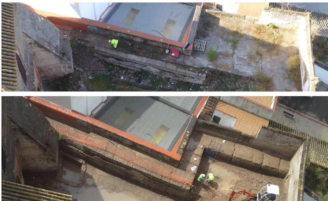
FIGURA 6. Vistas aéreas de la muralla durante el proceso de excavación.
