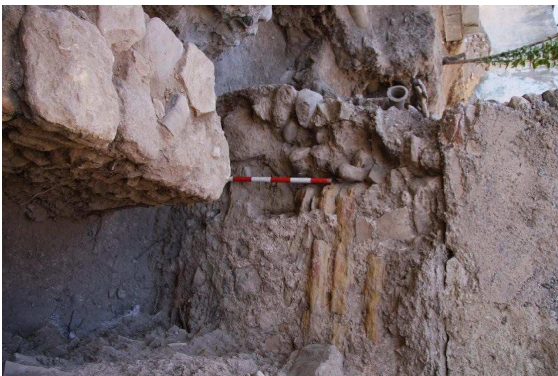
Fig 29 - Lateral del torreón en el que se observa la fábrica interior y la diferencia de plano entre el enfoscado localizado soterrado y la línea actual de frontal del torreón.
