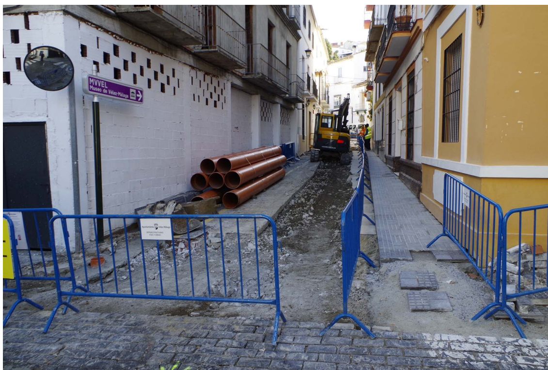
Lám. 1. Foto inicio de los trabajos.
