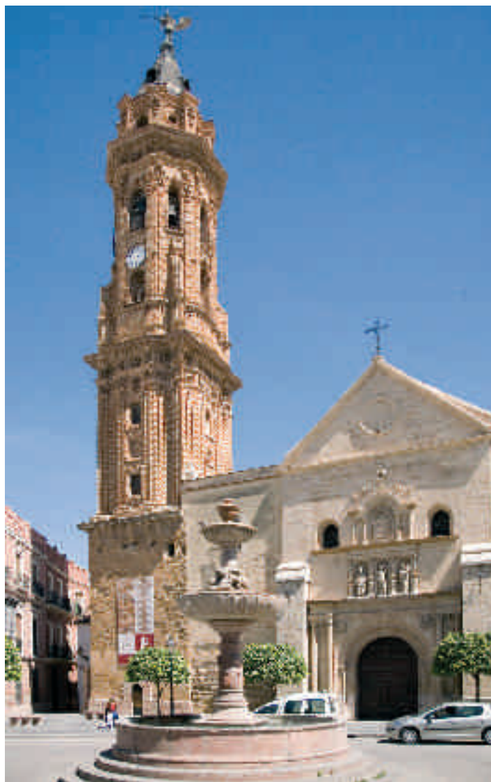
Torre y fachada. Colegiata de San Sebastián, Antequera (Málaga).
