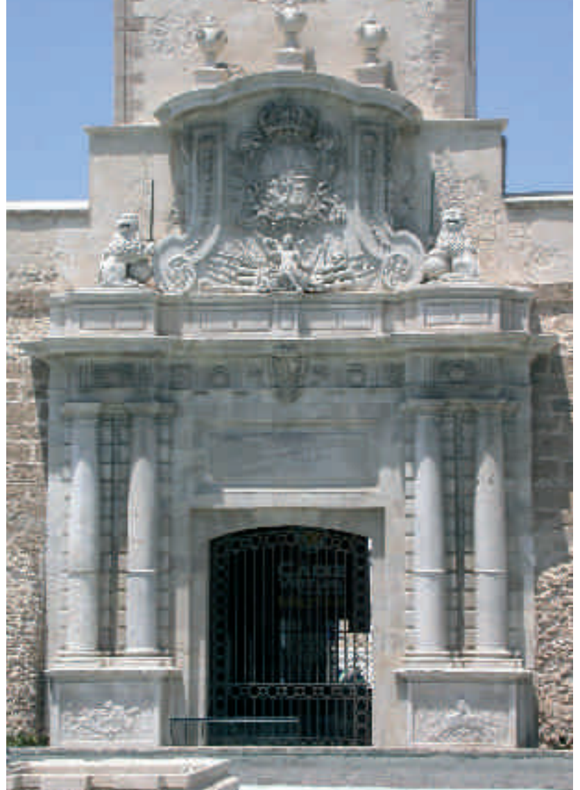
José Barnola y Torcuato Cayón , Puerta de Tierra (1751-56), Cádiz.
