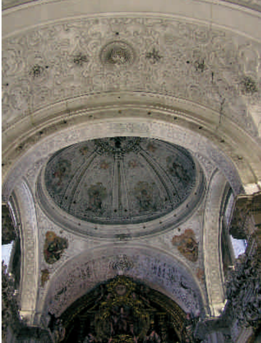
Cúpula. Iglesia del Hospital de la Caridad, Sevilla.
