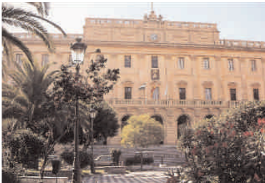
Torcuato Cayón, Ayuntamiento (c. 1780), San Fernando (Cádiz).
