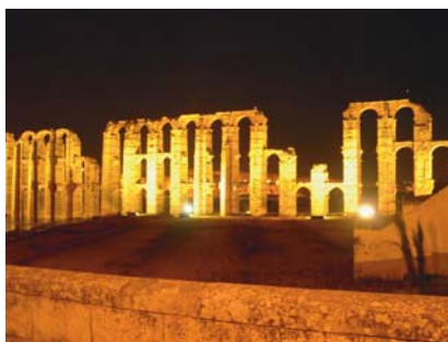
Acueducto de los Milagros, Mérida
