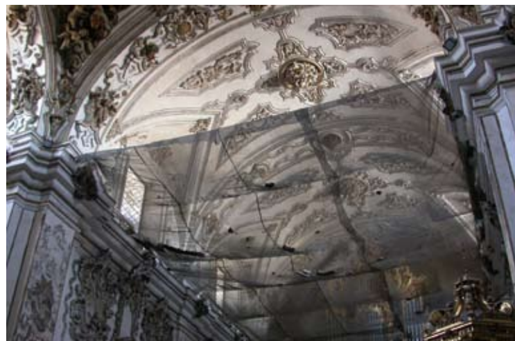
Nave central antes de la restauración.
