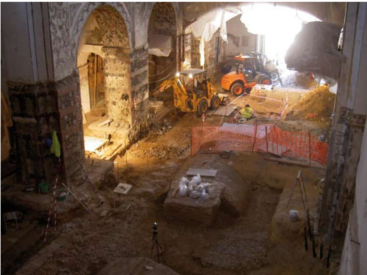
Estado del templo durante la intervención.
