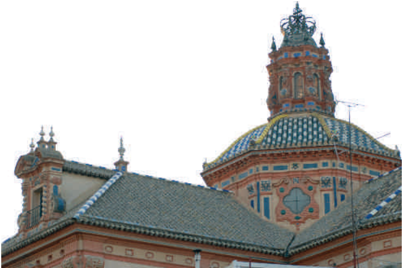
Leonardo de Figueroa , Cubiertas (detalle). Iglesia del Convento de San Pablo, Sevilla.
