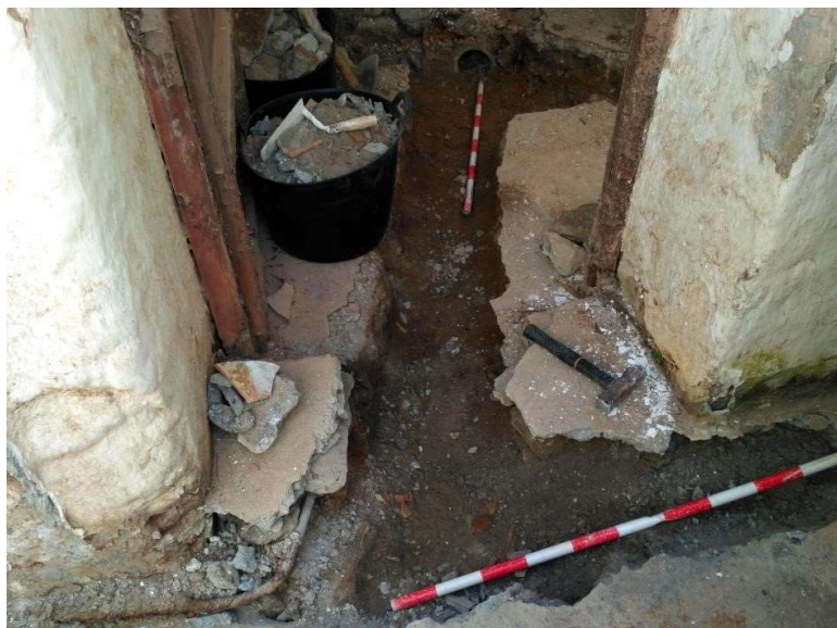
Fig. 2. Vista de la zanja de las acometidas en la entrada de la casa y de la arqueta.
