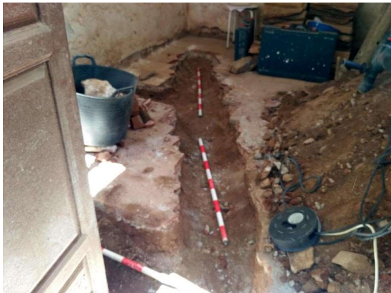
Fig. 1. Vista de la zanja de las acometidas del baño.
