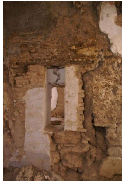
F.20 Muro medianero entre habitaciones 01 y 02 construido sobre otro anterior.
