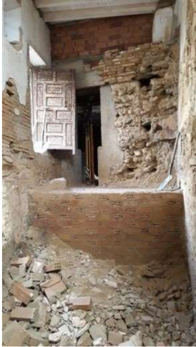
F.21. Plataforma contemporánea, adosada a la pared norte, para recrear nivel de suelo de la planta baja en San Martín 12.
