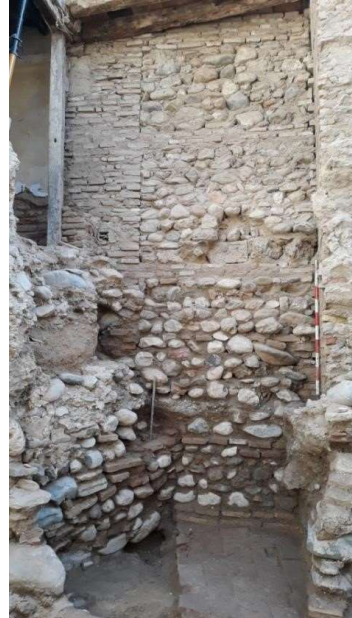
F.27 Pared Este de la habitación 11, medianera con patio principal en su esquina suroeste acceso a la
