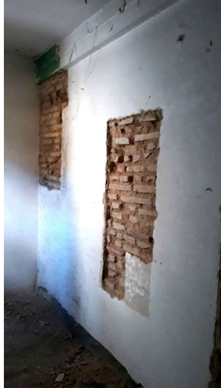
F.08 Estado final de las catas 01 y 02 en la galería 04 .
