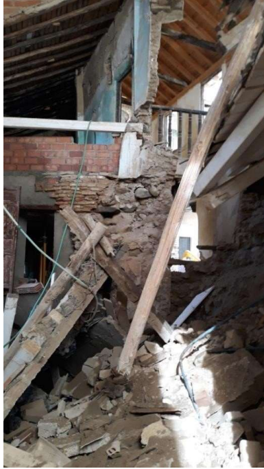
F.24 Colapso y pérdida de la pared Este de la habitación 03 escombros. Fábrica realizada con mampostería sobre niveles limosos propios del sustrato geológico
