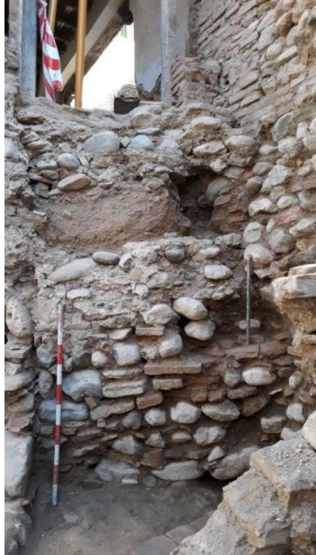
F.26 Pared norte de la habitación 11. Sobre ella se desarrolla la estructura vinculada con las escaleras de planta primera de San Martín 12 desde el patio principal
