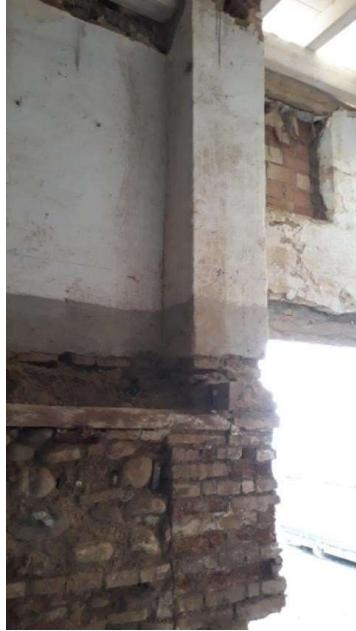
F.18 Línea de forjado entre planta baja y primera
