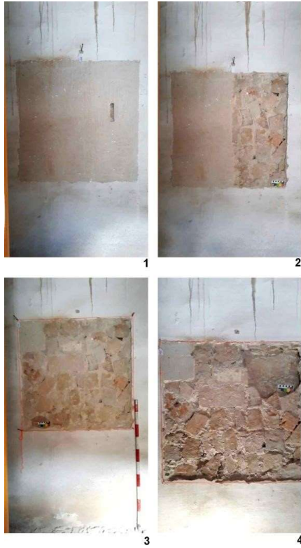
F.12 Proceso de realización de cata 01. Sala 07
