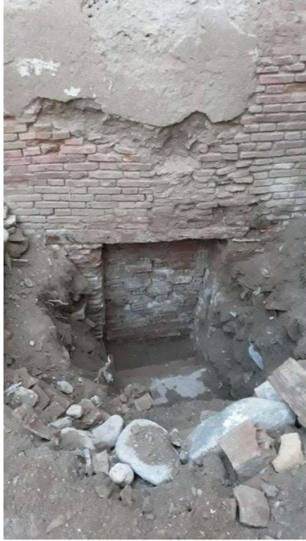
F.35 Puerta de acceso desde la habitación 03 al patio su extremo sur.
