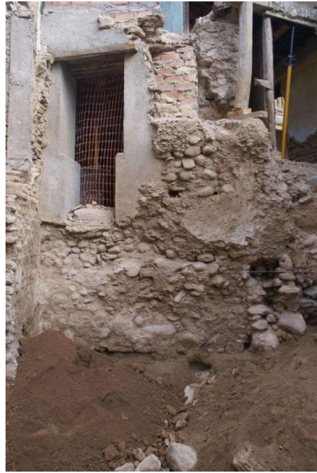
F.24 Colapso y pérdida de la pared Este de la habitación 03 escombros. Fábrica realizada con mampostería sobre niveles limosos propios del sustrato geológico
