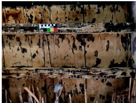
F.05 Jaldetas del alfarje de la galería 04, decoradas formas redondeadas en su eje central y gramiles en desarrollo lateral. En el tablazón no se aprecia
