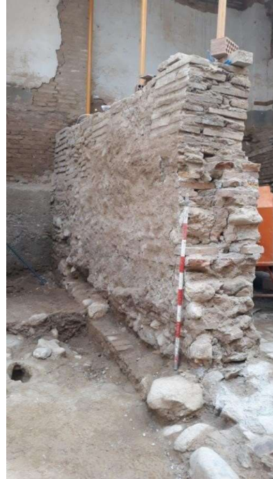
F.20 Muro medianero entre habitaciones 01 y 02 construido sobre otro anterior.
