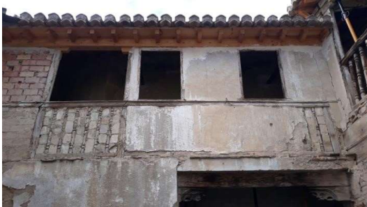
Lámina 01: Pórtico sur -1-, pórtico y galería norte -2- y galería oeste -3- del patio principal de San Martín 12 en momentos previos a la intervención.
