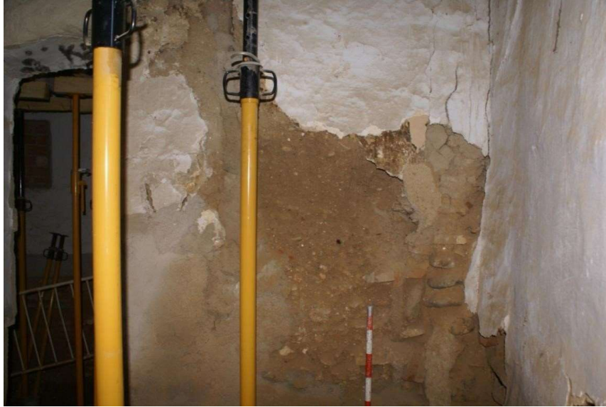
F.23 Muro realizado con tapial de arena, que delimita la habitación 01 y 02 por su extremo oeste. Cara vista desde habitación 02 en planta primera.
