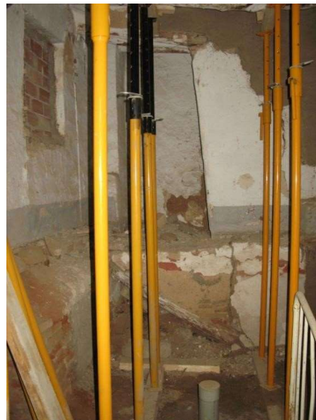
F.02 Interior de la habitación 01 (crujía sur) en momentos previos a la intervención. En la imagen se aprecia el rodapié que marcaba el nivel de suelo de la planta primera. Al fondo se localizaban las escaleras de acceso entre plantas. En el hueco de las escaleras (mitad derecha) se encontraba el aseo.
