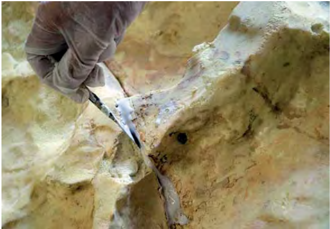
Lámina 10.40. Introducción del yeso en la junta de unión desde la cara interna.
