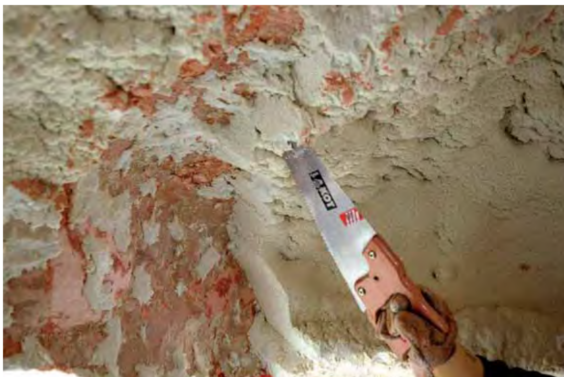
Lámina 10.78. Desbastado con serrucho.
