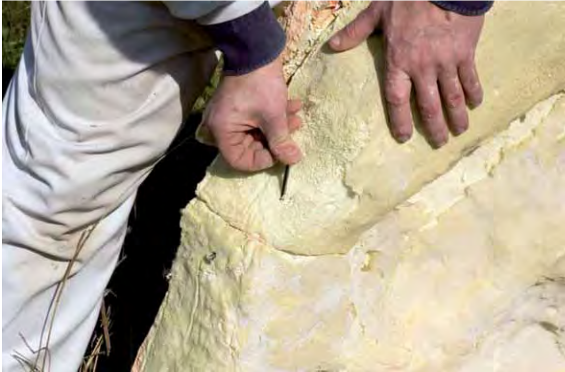
Lámina 10.37. Fijación del fragmento hasta la polimerización de la resina mediante “cosido” con los clavos.
