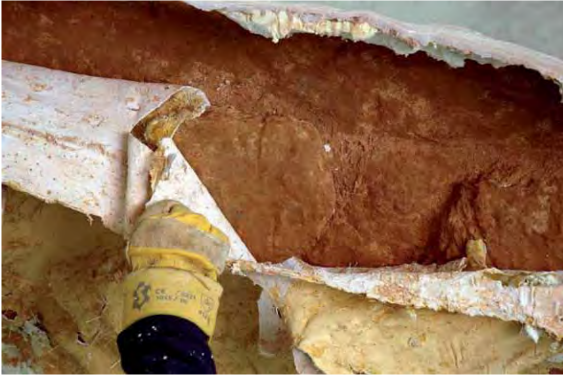
Lámina 10.86. Imagen de la separación de la silicona desde el borde en la que se distinguen los alfileres.
