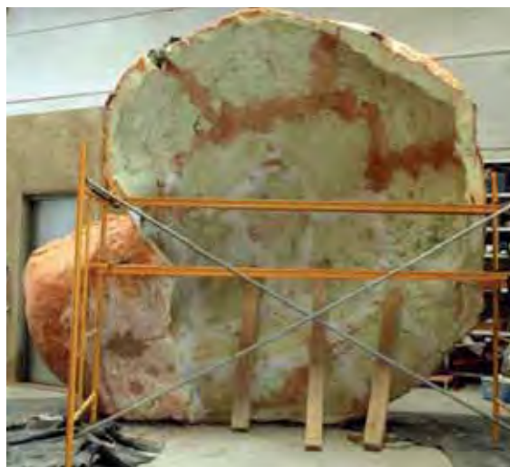
Lámina 10.75. Inclinación del molde en una posición vertical para recubrir zonas ocultas. También apreciamos la estructura en red circular que caracteriza el despiece del poliuretano.
