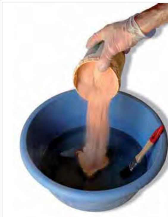
Lámina 10.64. Incorporación de la tierra tamizada.
