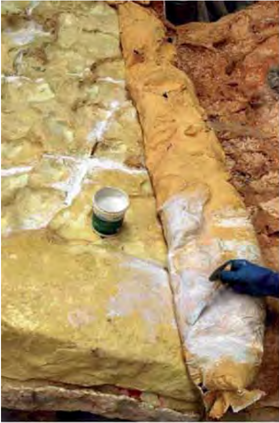
Lámina 10.55. Aplicación del adhesivo.
