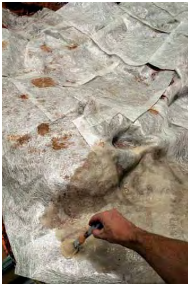
Lámina 10.69. Solapado de la fibra.
