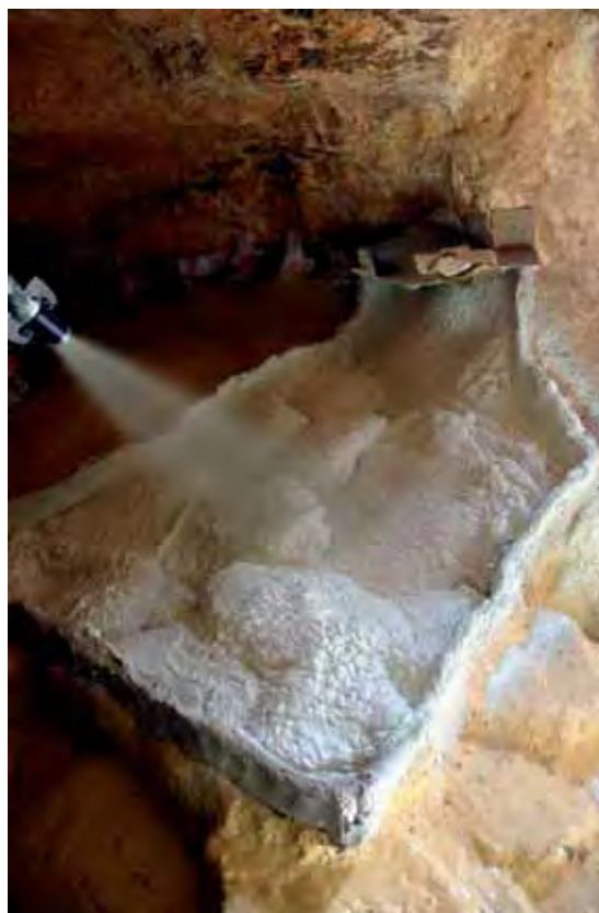
Lámina 10.12. Proyección de la espuma de poliuretano.
