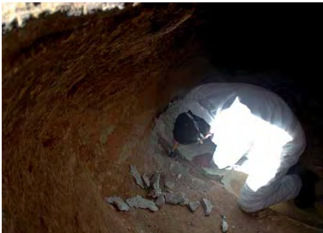
Lámina 10.17. Eliminación del tabique de yeso.
