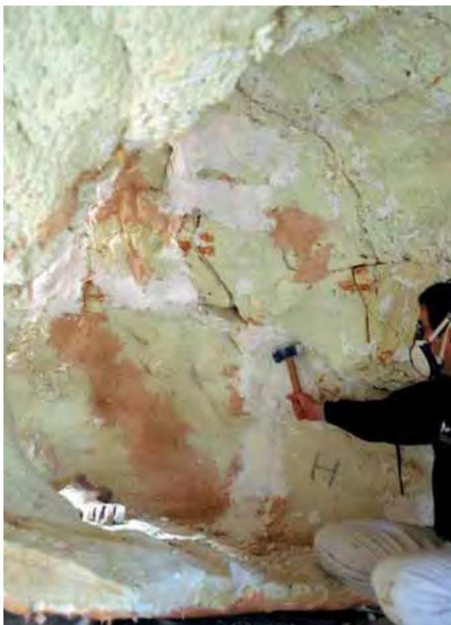
Lámina 10.77. Interior de la bóveda. Eliminación de las uniones de yeso.
