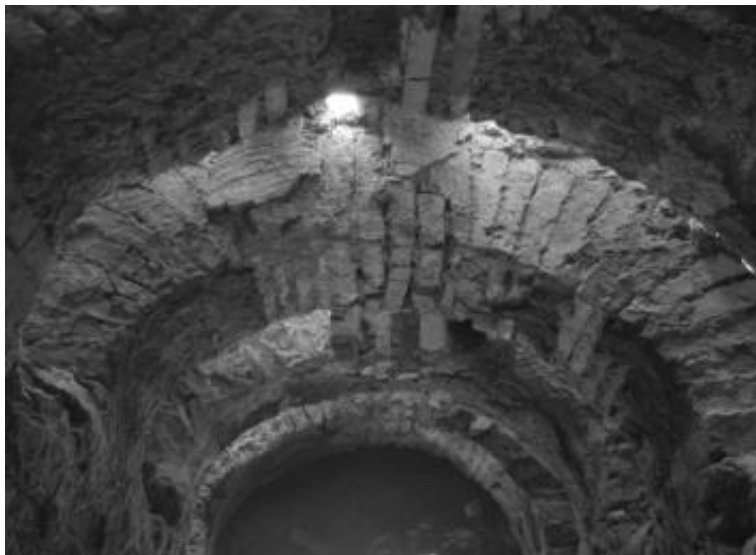
53.- Arcos de la suspensurae del Horno I de Villa Victoria, en Puente Mayorga (San Roque, Cádiz).
