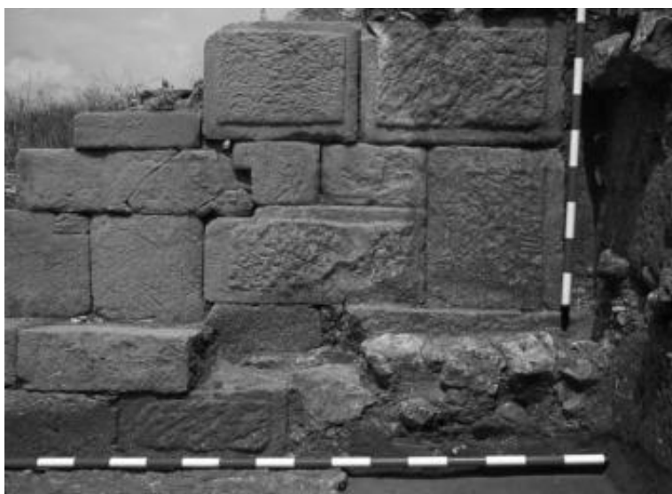
98.- Detalle del mismo tras la excavación de 1995.
