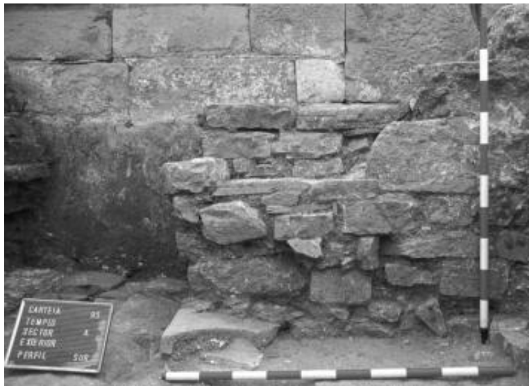
163.- Detalle del muro adosado al podium del templo. Corte C.3. Campaña de 1995.
