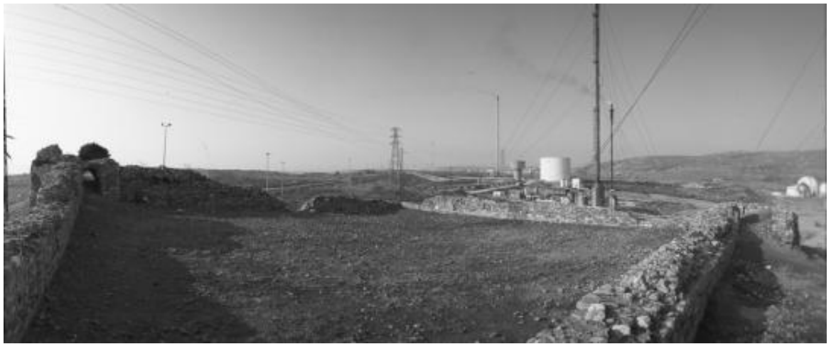
191.- Vista general del interior de la fortaleza Torre Cartagena. Campaña de 1995.
