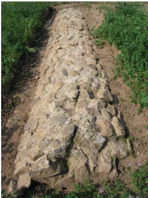
Lámina IX. Acueducto de Valdepuentes. Bóveda de opus caementicium.
