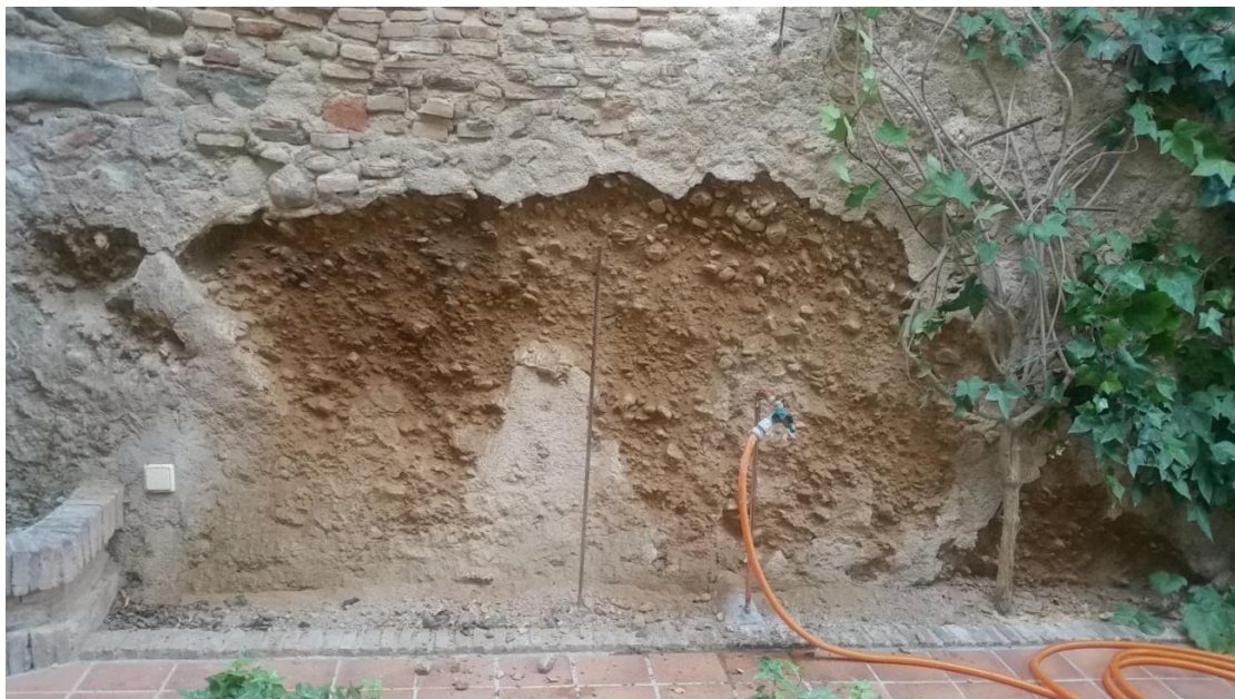
Figura 3. Detalle del estado del lienzo antes de la intervención arqueológica preventiva
