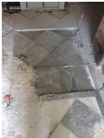
Levantamiento de las losas hidráulicas
