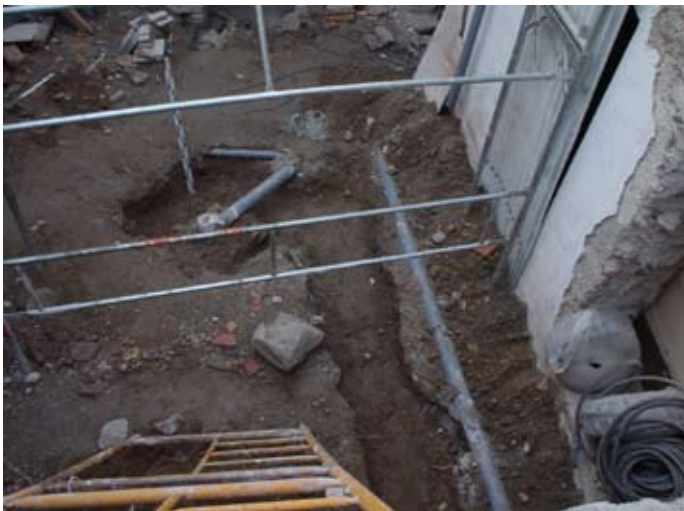
Lámina I. Redes de saneamiento e hidráulica en la zona del patio trasero.
