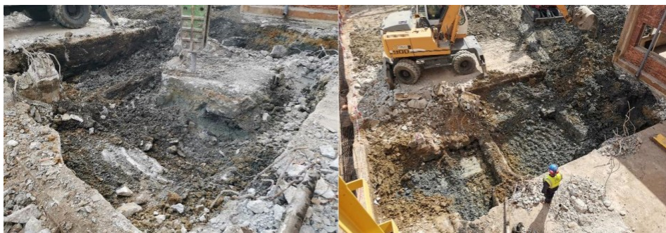
Lámina 2. Cimentaciones descubiertas.
