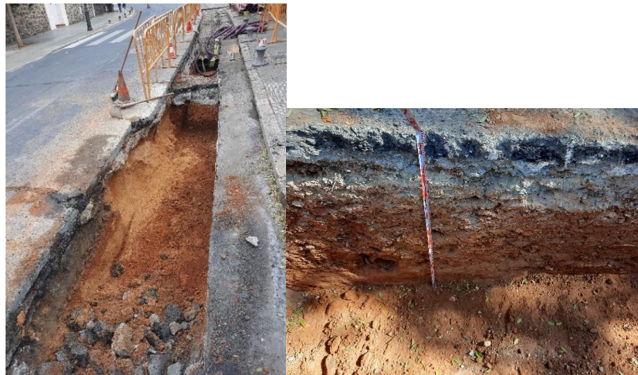
Figura 10 y 11: Proceso de excavación Avda. Manuel Siurot: zahorra natural de color anaranjada, de composición arcillosa con gravas.
