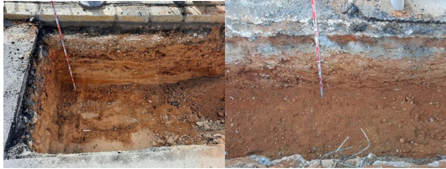
Figura 8 y 9: Proceso de excavación Avda. Manuel Siurot: Form. Arenas de Huelva contaminada con zahorra natural.
