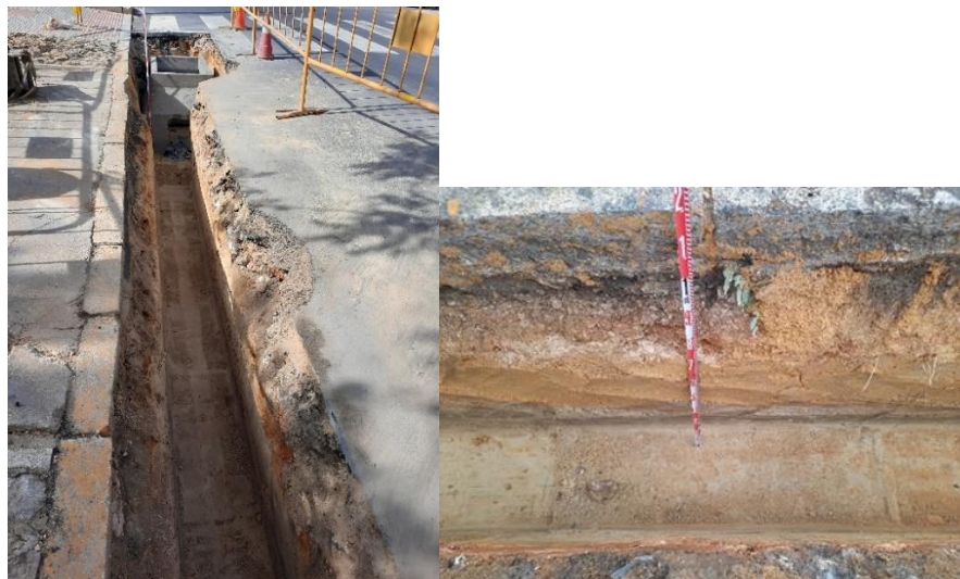
Figura 14 y 15: Proceso de excavación de la zanja en la C/Marchena Colombo: estrato Form. Arenas de Huelva.
