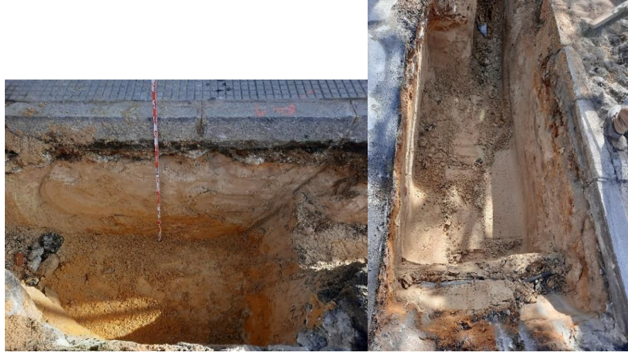
Figura 12 y 13: Proceso de excavación de la zanja en la C/Rafael Pavón y C/Marchena Colombo, respectivamente, Form. Arenas de Huelva.
