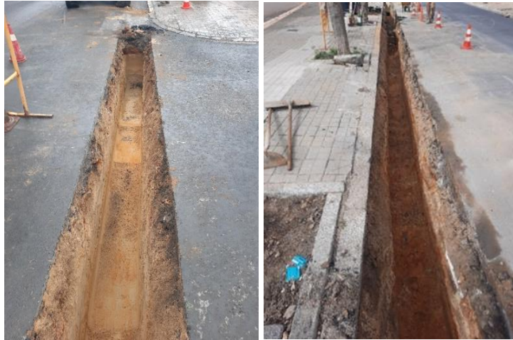
Figura 16 y 17: Proceso de excavación de la zanja en la C/Marchena Colombo: estrato Form. Arenas de Huelva.
