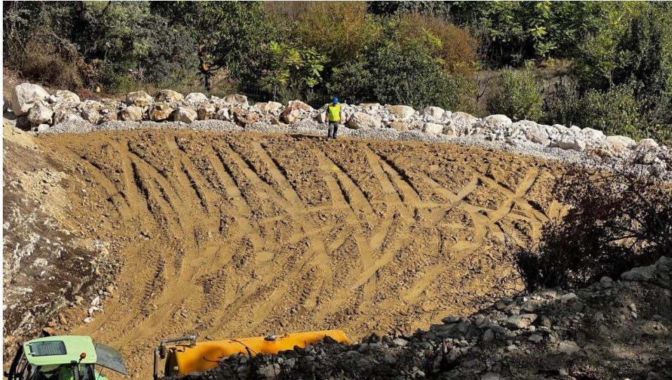
Muro de escollera y compactación del terreno
