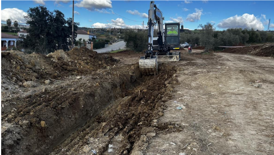
Trabajos de apertura de zanjas en Colector G4 (Urb. El Olivar)
