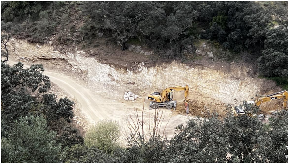
Rebaje del talud en la EBAR principal
