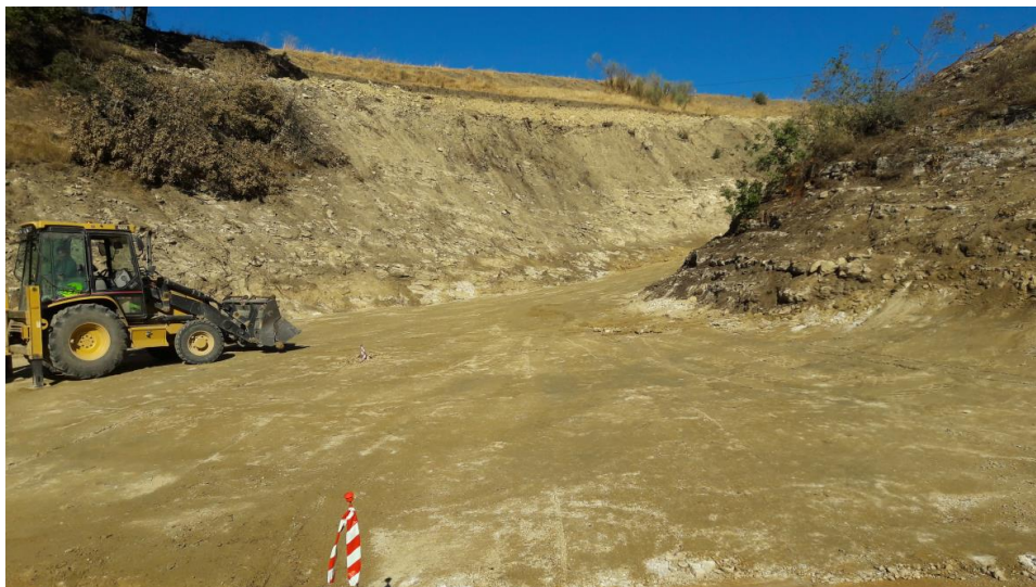
Zona baja (Sur) tras el relleno de zahorra y el compactado
