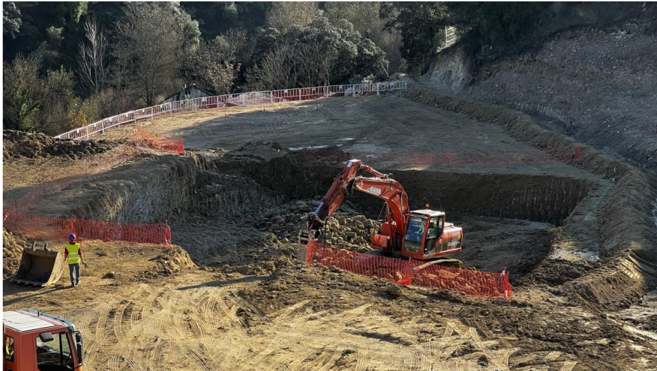
Rebaje mediante picado donde irá ubicado el reactor biológico
