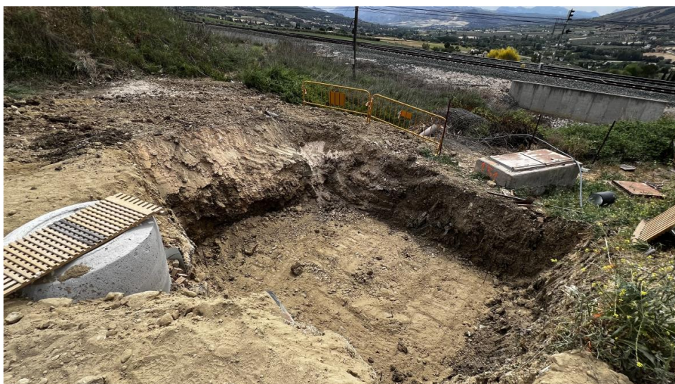
Trabajos de excavación para preparar la cimentación de la EBAR del Polígono
