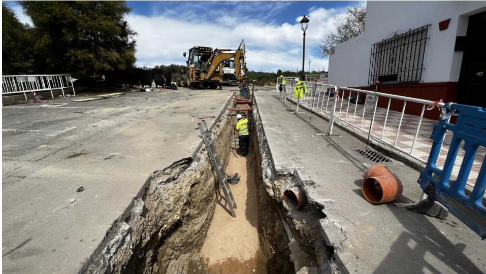
Trabajos de apertura de zanjas en Colector G4, pozo nº 33
