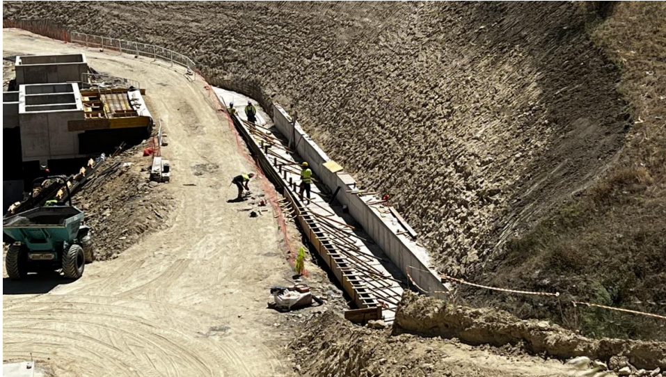
Trabajos en el canal de drenaje perimetral de la EDAR
