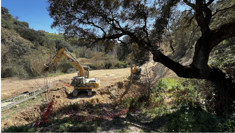
Trabajos de excavación para la cimentación de la estructura de la EBAR principal
