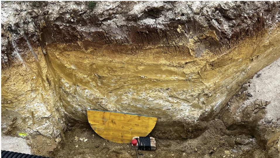
Perfil estratigráfico del sondeo del Colector de gravedad G4, pozo nº 8
