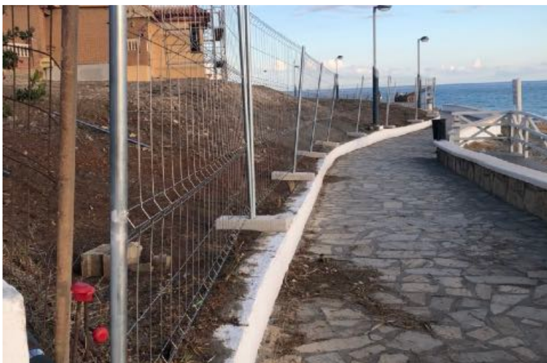
11. Vallado provisional de la zona suroccidental de la parcela. Vista desde el noroeste.
