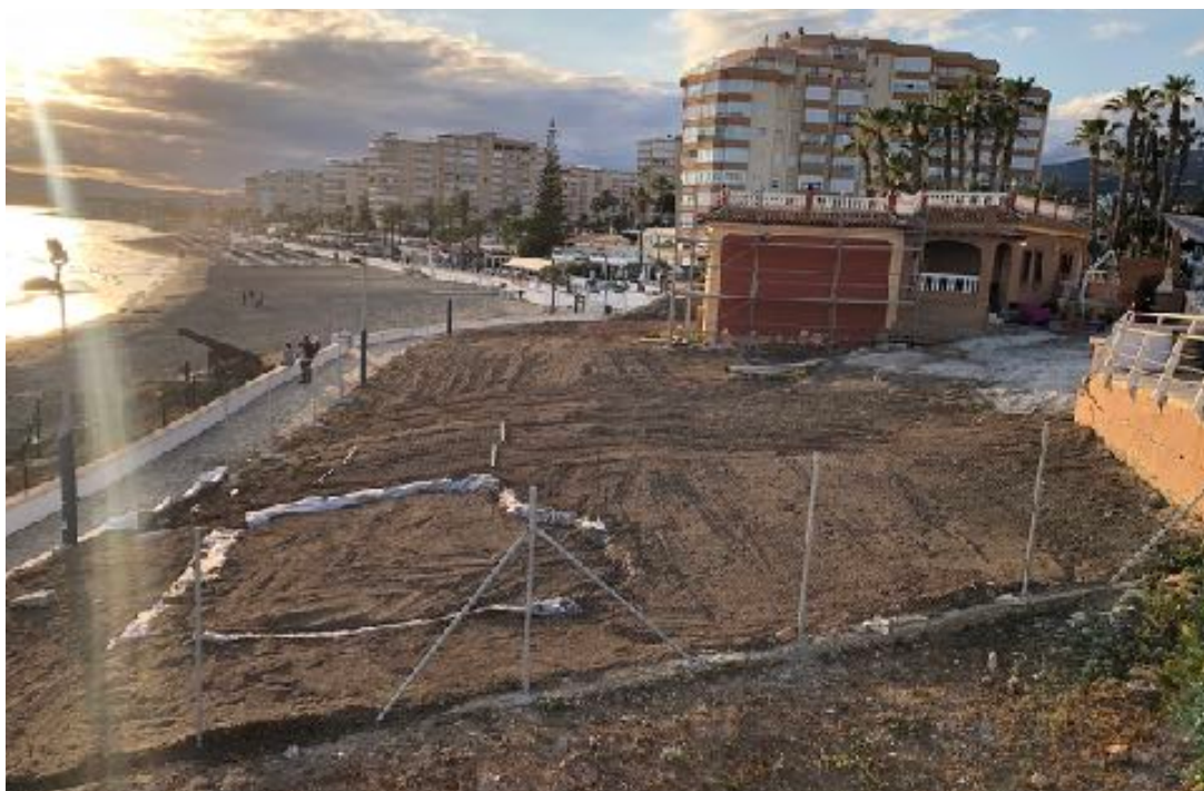
9. Estado final de la parcela y del sondeo 1 tras la limpieza. Vista desde el este.
