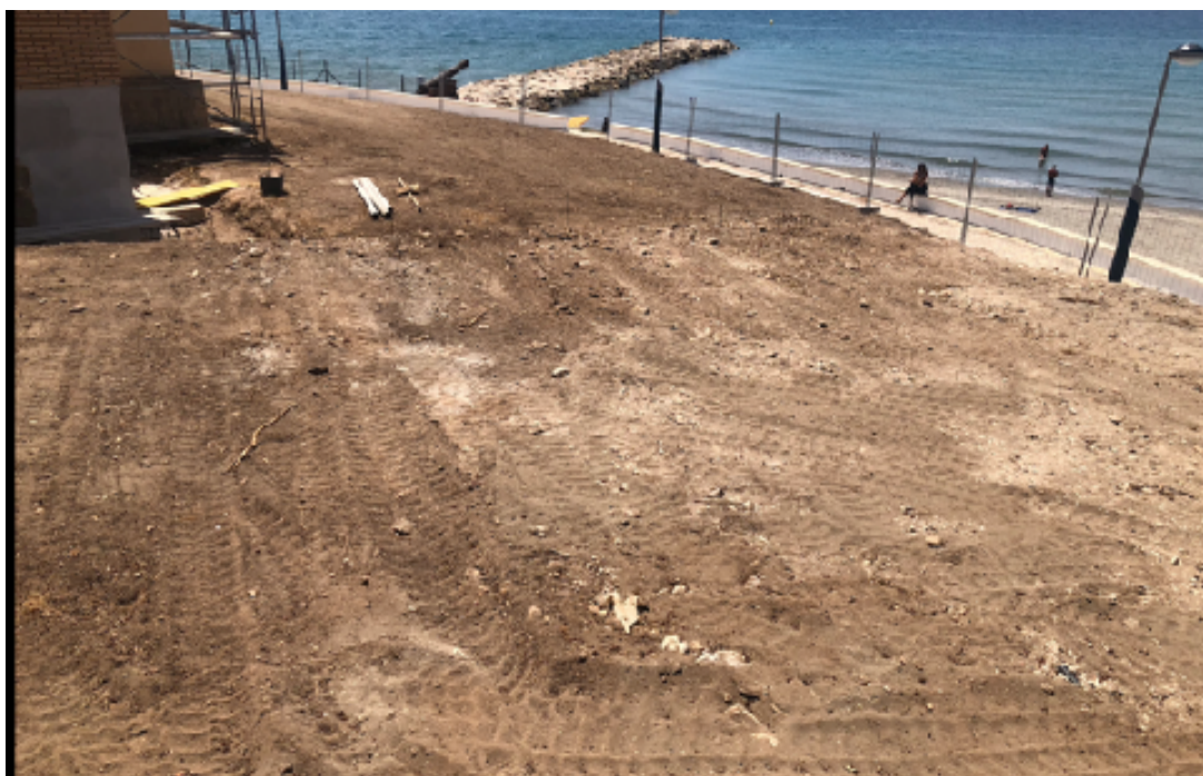
10. Estado final de la parcela y del sondeo 2 tras la limpieza. Vista desde el noroeste.
