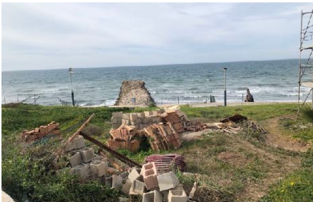
4. Vista de la parcela antes de la retirada del material de construcción
