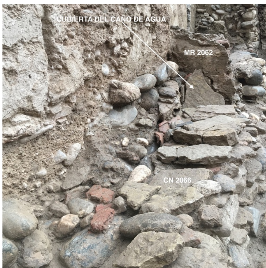
Figura 11.- Acequia CN 2066 con su cubierta
