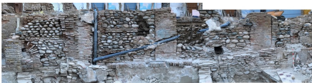
Figura 8.- Vista general del paramento del MR 2011
